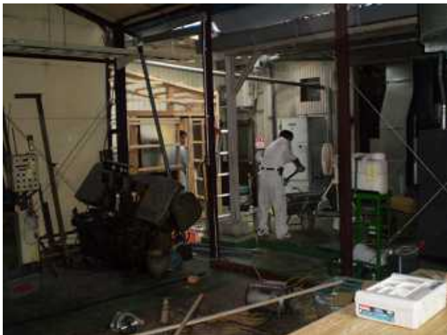
工事中の風景
